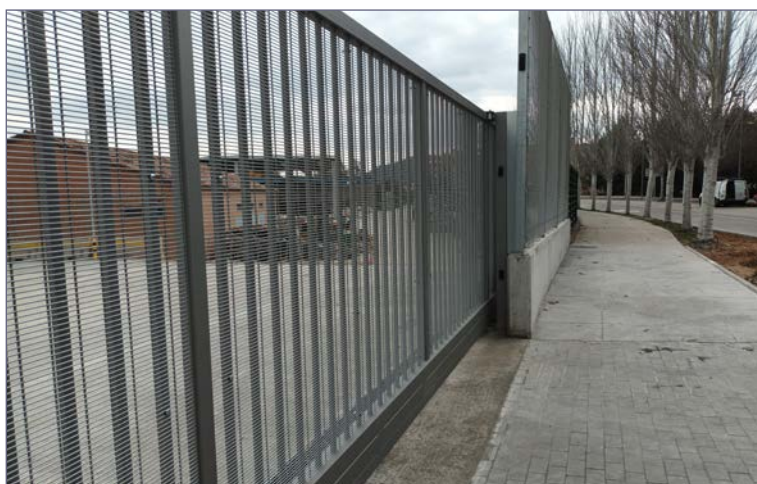
Puerta corredera autoportante de grandes dimensiones (sistema de apertura de la puerta sin rail inferior).
