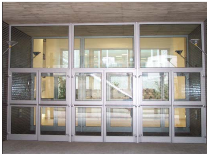
Conjunto puertas entrada dos hojas con fijos superiores.
